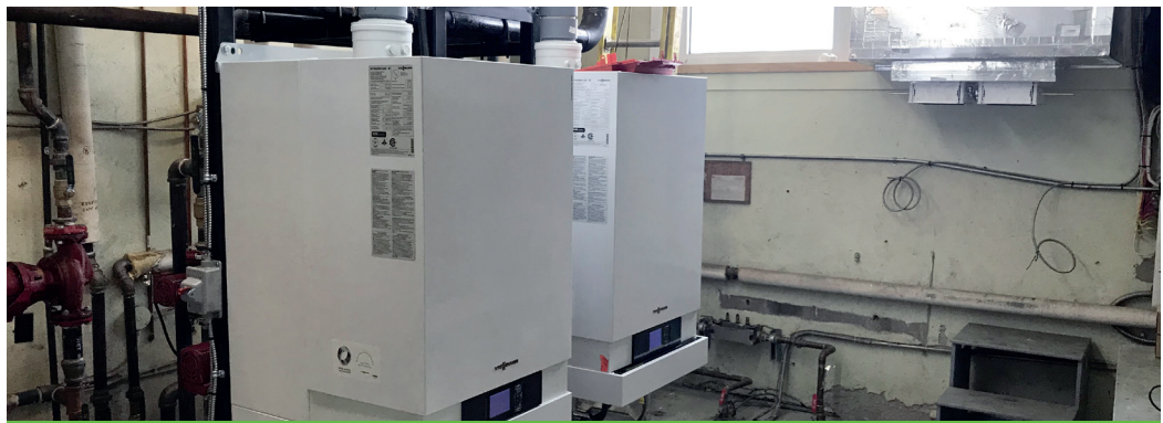
École Sainte-Marie : Travaux de remplacement des chaudières
