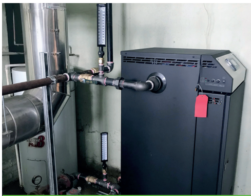
École Saint-Isidore : Installation des chaudières
